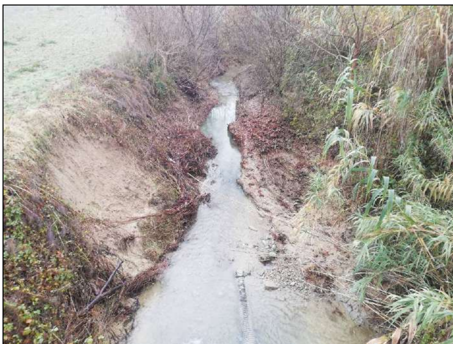
Ripresa fotografica delle scarpate spondali erose e in dissesto a valle dell'attraversamento (int. 1.2) riprese da monte (SW)
