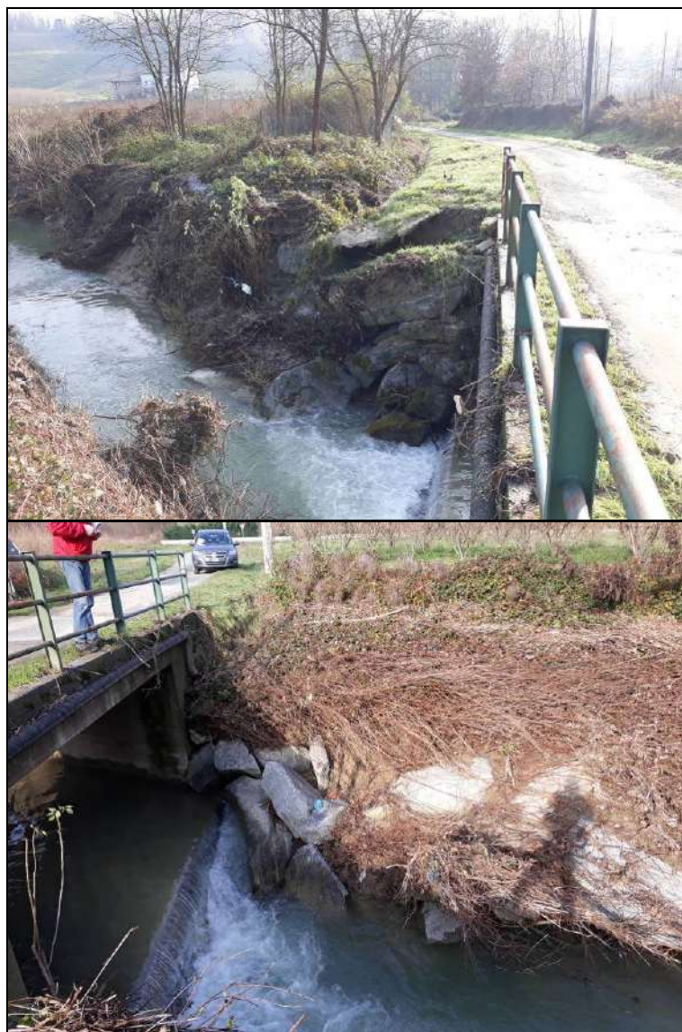
Ripresa fotografica delle scogliere spondali in sponda destra (in alto) e sinistra (in basso) al Rio Cervino (int. 7.2)
