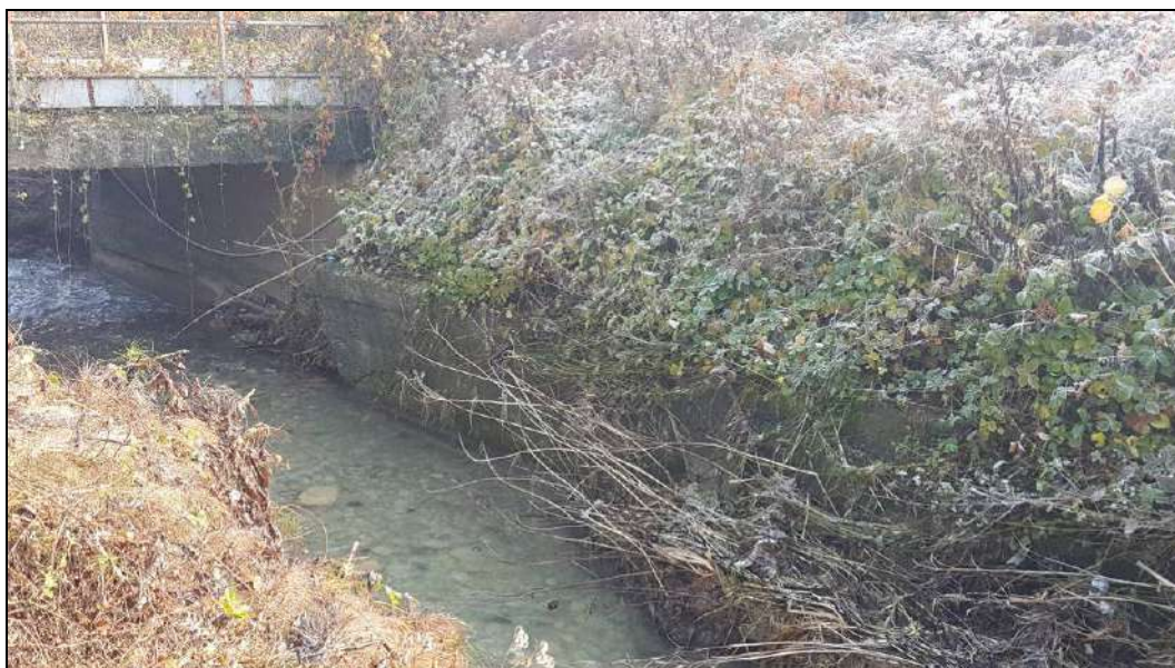
Ripresa fotografica del muro spondale ruotato a monte dell'attraversamento da SW (int 8.1)
